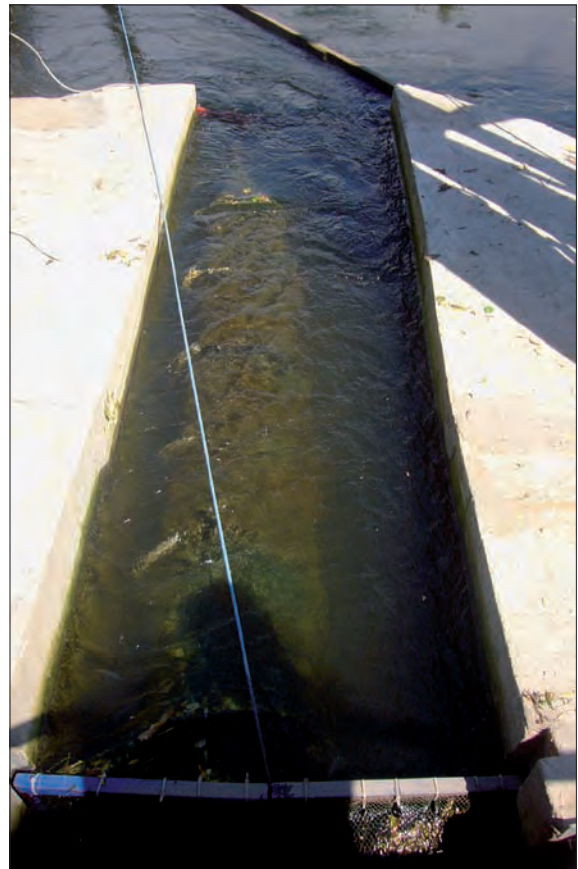
Umgehungserinne mit Reuse zur Fischdurchgangsmessung (Foto: DVL)
