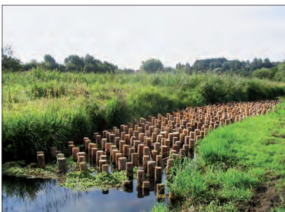
Sohlanhebung Malenter Au mittels Eichenspaltpfählen (Foto: WBV Ostholstein)
