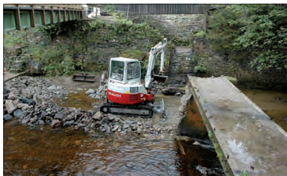
Beseitigung von Wanderbarrieren – hier ein Wehr an der Rur (Foto: Biostation Aachen)
